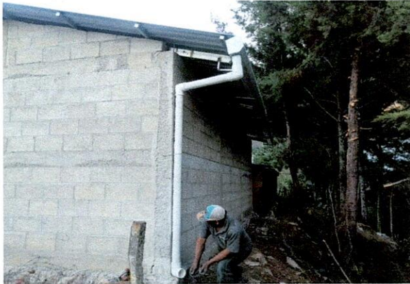
Foto 3: Mejoramiento de aulas
